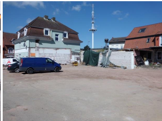
... und laufender Abbruch
