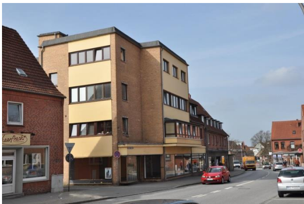
Berliner Straße 10 (Zeitpunkt VU)
