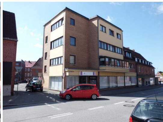
Berliner Straße 10 (nach Leerstands-beseitigung)
