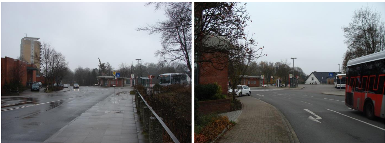
Askaniering mit ZOB; unübersichtliche Zufahrten; Kiosk im Hintergrund
