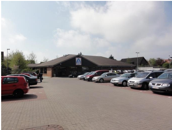
Hamburger Straße 33-35 (ALDI) vor Neubau
