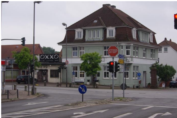
Berliner Straße 28 (Zeitpunkt VU)
